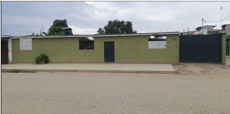
Vista externa del Patio de Maniobras donde se guardan los vehículos tipo Hidrocleaner
