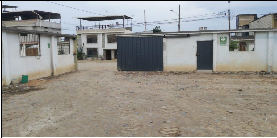
Acceso Principal al patio de maniobras donde se guardan los vehículos tipo Hidrocleaner
