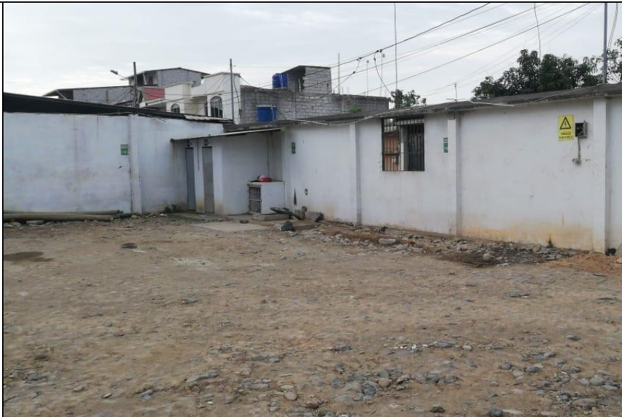
Área de baterías sanitarias
